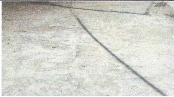
Foto 3: Reparación de piso de torta de concreto
