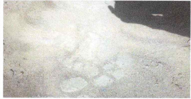
Foto 2: Reparación de piso de torta de concreto
