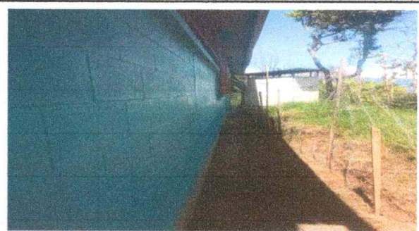
Foto 4: Reparación de muro perimetral de blok con tuvo HG y malla galvanizada, solera intermedias y columnas
