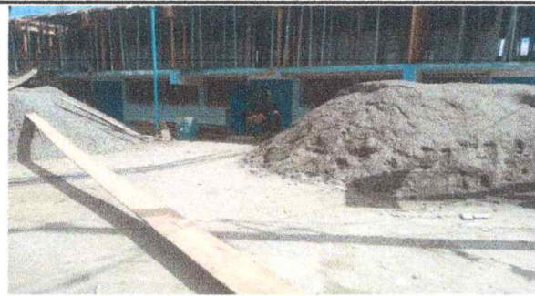
Foto 5: Reparación de piso de torta de concreto
